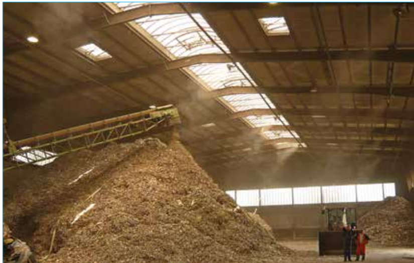
Recyclefabriek biomassa en RDF (Energie Voor Afval). Brockman Duitsland
