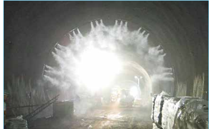
Tunnelgraafwerkzaamheden voor de nieuwe metrolijnen in Londen & Edinburgh
