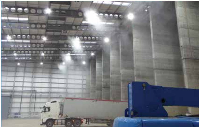
Stort hal - Verneveling bestrijdt verspreiding van stof en stank
